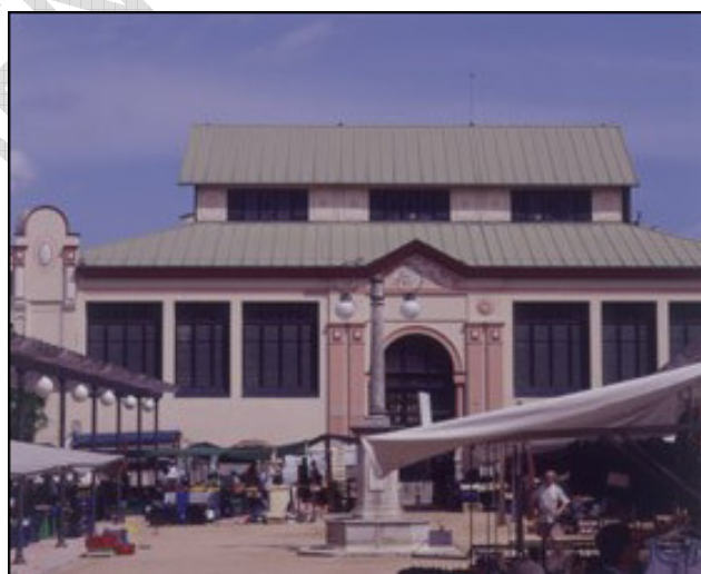
Rehabilitación de cubierta de un mercado
