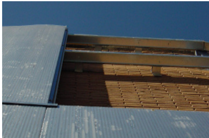
Fachada rehabilitada con paneles por el exterior
