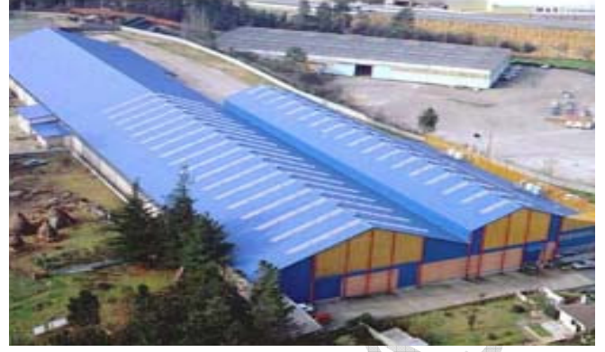
Cubierta y fachada de nave industrial
