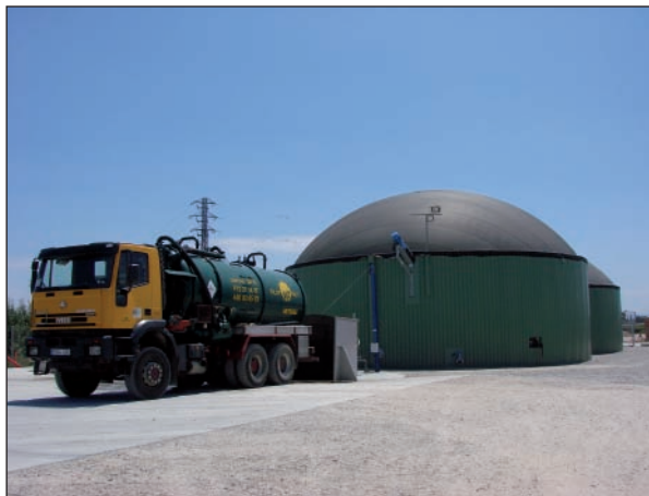
Descarga de residuos orgánicos en la planta.
