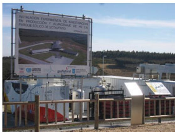
Instalación experimental de investigación en producción y almacenaje de H<sub>2</sub> en el Parque Eólico de Sotavento (Xermade, Lugo)
