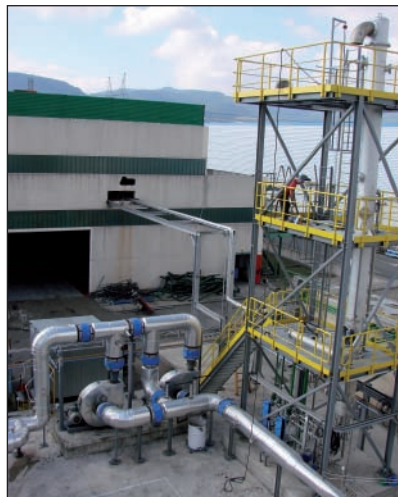
Arriba, filtro cerámico de syngas verde. A la derecha, soplantes y torre del scrubber. Fuente: GUASCOR.
