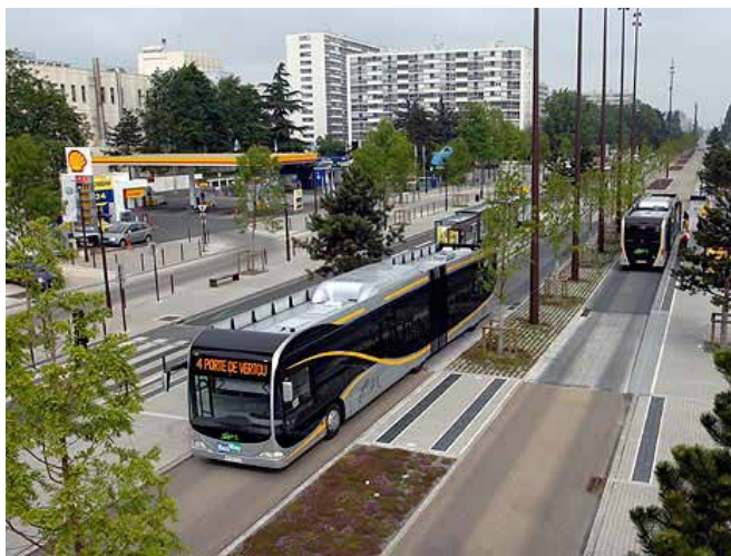
BUSWAY DE NANTES
