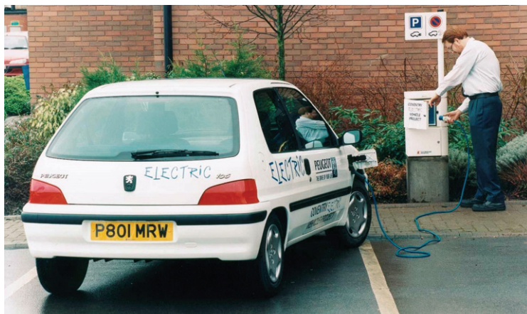
Recarga de batería de un vehículo eléctrico
