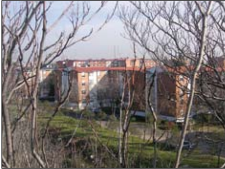
Figura 6.2: Bloque de viviendas con calefacción centralizada.
