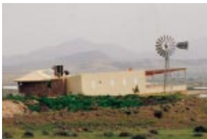
Instalación mixta eólico-fotovoltaica aportando energía a un consumidor aislado
