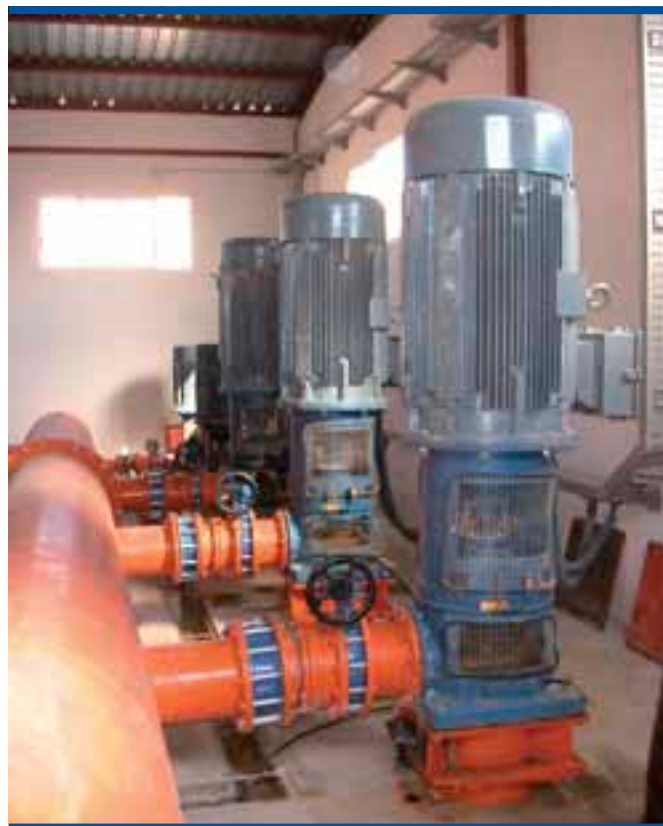
Foto 11. Estación de bombeo con grupos de diferente tamaño en la comunidad de regantes de Albaterra
