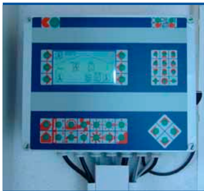
Figura 3.13. Equipo electrónico para la regulación integrada de todos los sistemas de climatización de una nave ganadera
