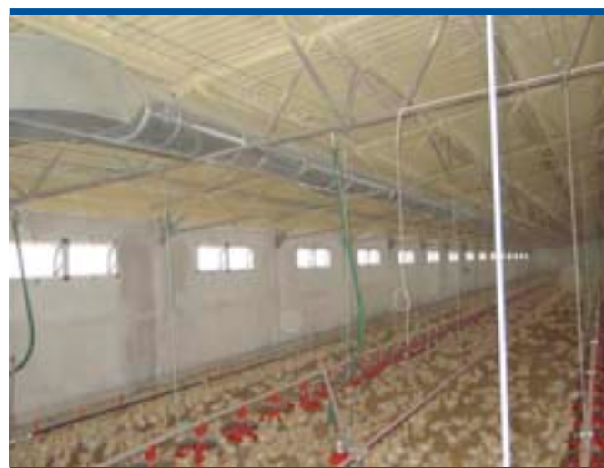
Figura 3.1. Aislamiento de la cubierta en una nave de pollos con poliuretano proyectado
