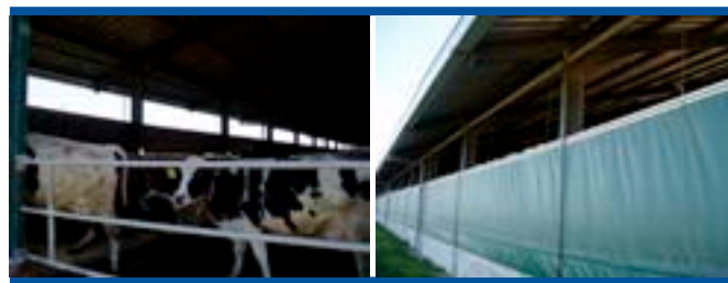
Figura 3.3. Ejemplo de barrera cortavientos móvil en un alojamiento de bovinos de leche (vistas interior y exterior)
