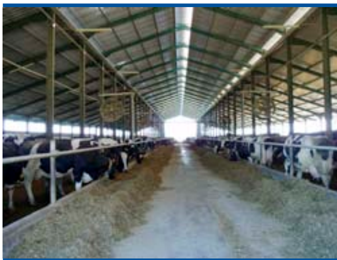
Figura 3.2. Imagen interior de una explotación de vacuno de leche, con ventiladores para la circulación del aire, dotados de nebulizadores de refrigeración
