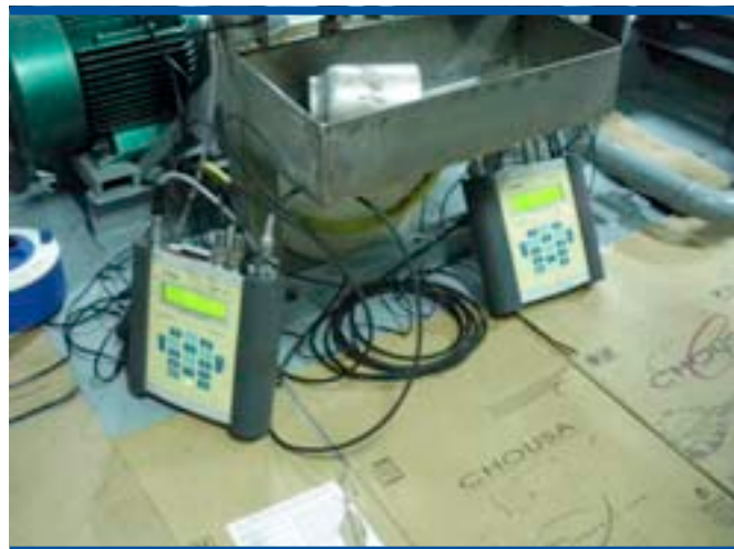
Fig. 4.1. Sensor de caudal (display) (Fuente y elaboración propias)
