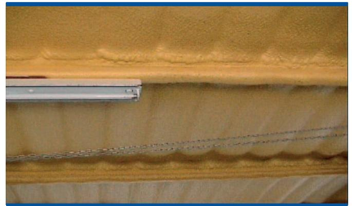
*Es importante cuidar el aislamiento de las cubiertas y el sellado de juntas entre cubierta y paramento vertical.*
