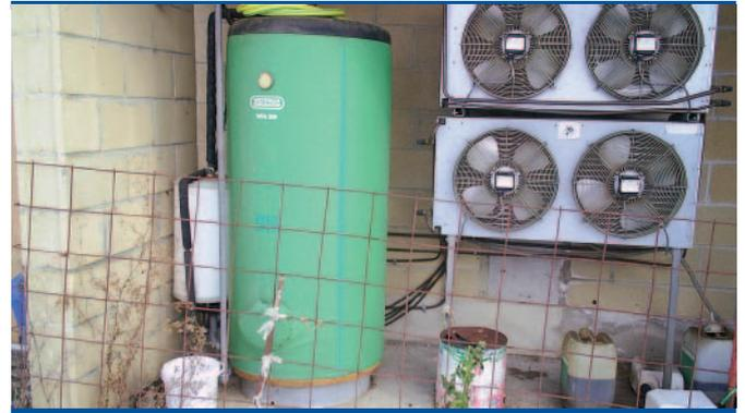
Acumulador de agua caliente calentada por el calor del tanque de leche. Compresores en el exterior.
