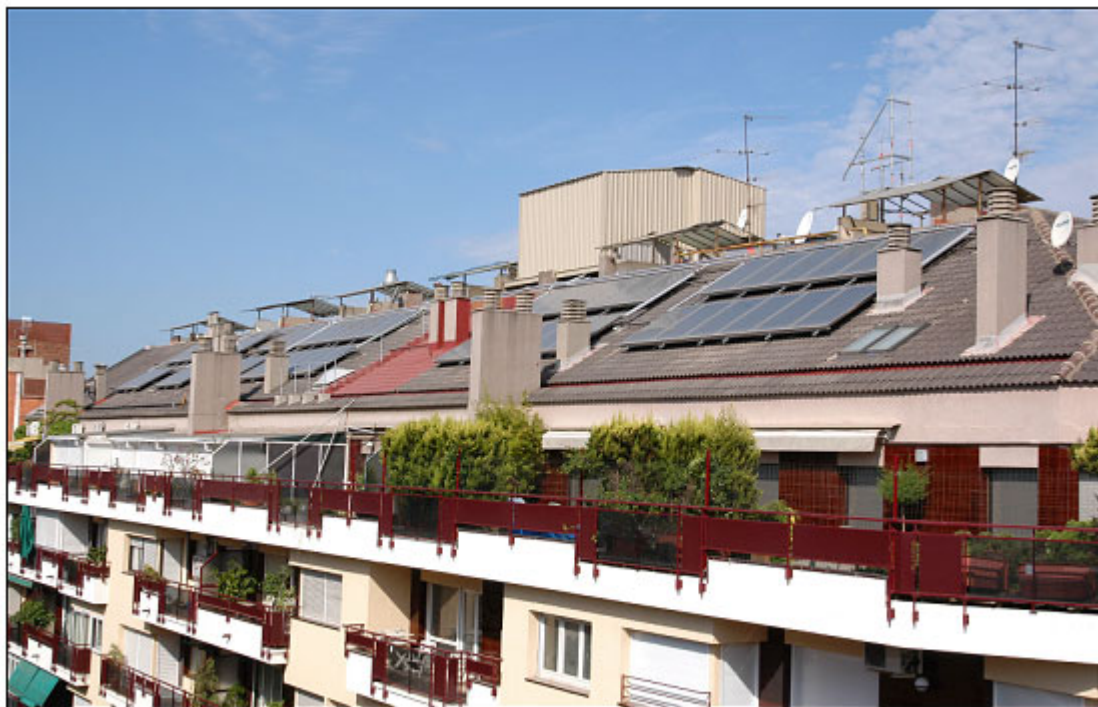
Vista parcial del edificio situado en la calle Guillermo Tell de Barcelona
