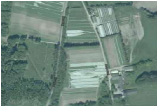
Figura 85: Instalación de Tars, Dinamarca. Año 2014. Se observa el campo de CCP totalmente finalizado mientras que la parte de espejos planos está siendo construida. (Fuente Google Maps)
