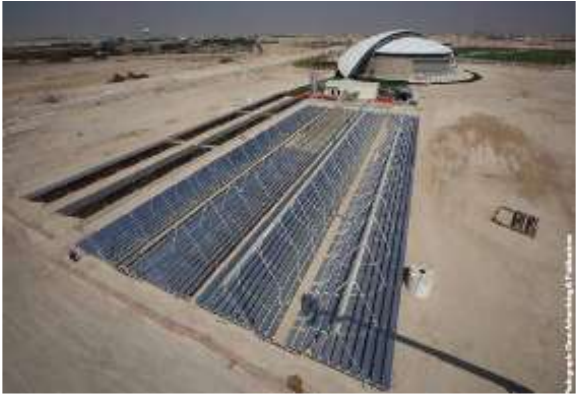
Figura 14: Instalación de Qatar. (Fuente: Solarthermalworld 6 )
