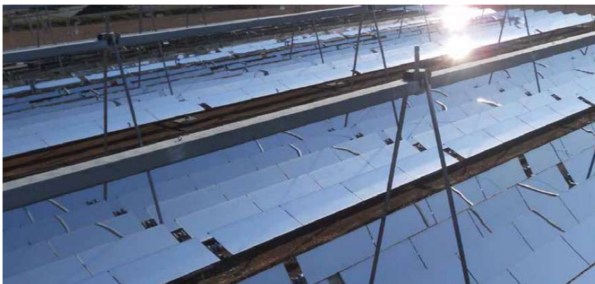
Figura 36: Colector de Fresnel. (Fuente: SOLTIGUA)
