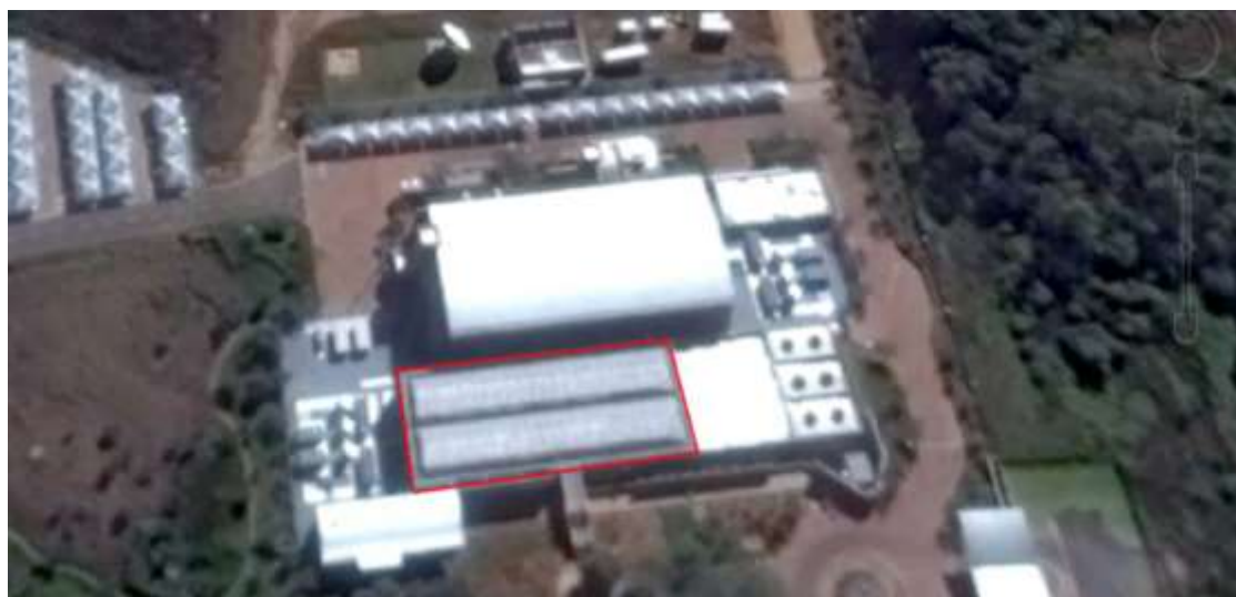
Figura 83: Instalación Fresnel de MTN en Sudáfrica. Superficie limitada por la línea roja ~ 1.100 m 2 . (Fuente: Google Earth)
