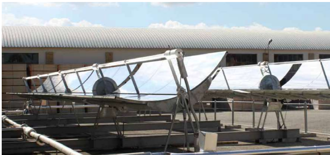
Figura 33: Colectores solares cilindro parabólicos. (Fuente: SOLTIGUA)
