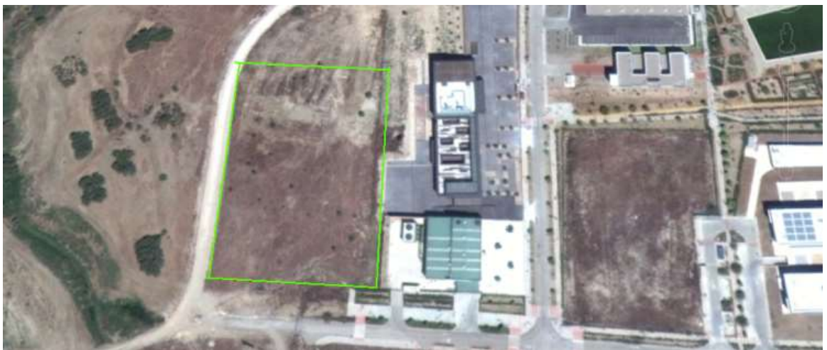
Figura 77: Fotografía de la parcela elegida para la ubicación del campo solar. Superficie limitada por la línea verde ~ 10.200 m 2 . (Fuente: Google Earth)
