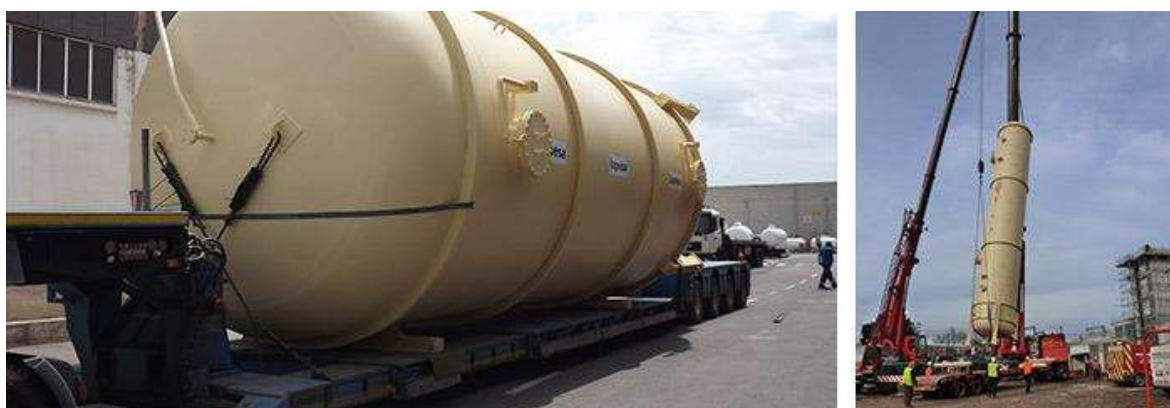
Figura 93: Depósitos para acumulación centralizada de agua caliente para utilización en circuitos de distribución para calefacción y producción de agua caliente sanitaria. (Fuente LAPESA)
