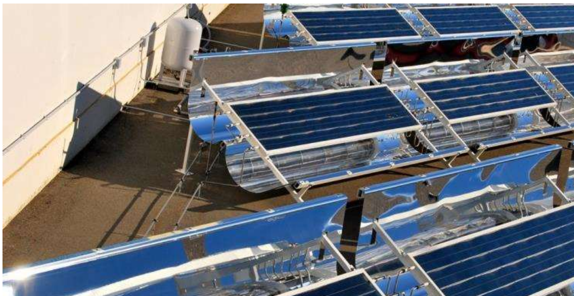
Figura 43: Captador de ultra alto vacío – UHV. (Fuente: SRB)
