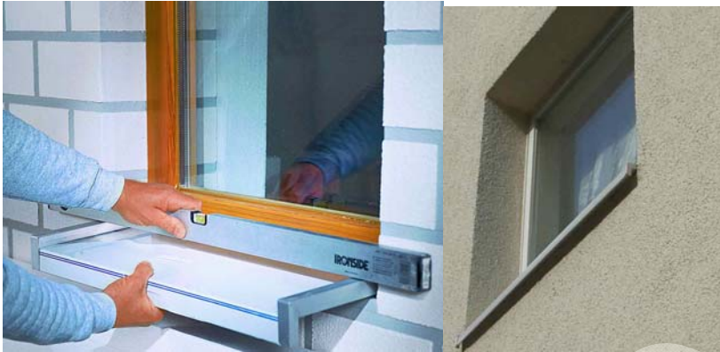
Figura 46. Detalle de un vierteaguas
