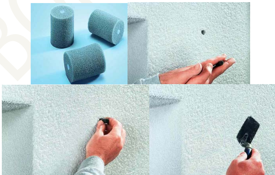
Figura 45. Detalle de una tapa de anclaje de andamio y su correcta instalación
