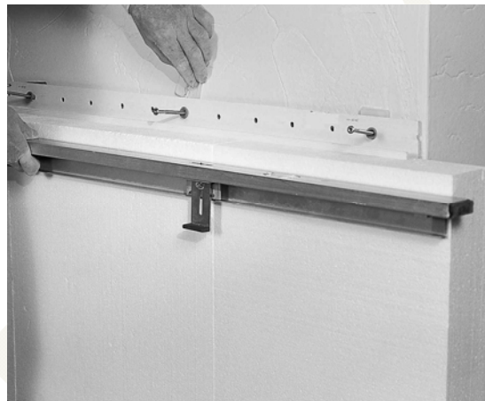
Figura 16. Fotografía de la instalación de un listón de retención.
