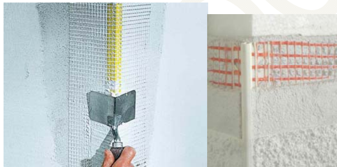
Figura 44. Detalle de aplicación de un perfil de esquina
