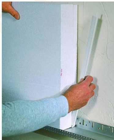
Figura 14. Fotografía de la instalación de los listones de unión.
