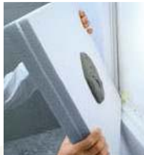
Figura 13. Fotografía del pegado de los paneles de aislamiento
