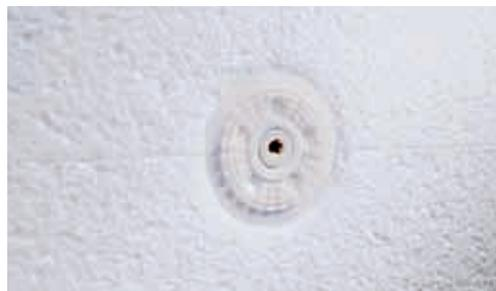
Figura 6. Detalle de la instalación de una espiga sobre el aislamiento
