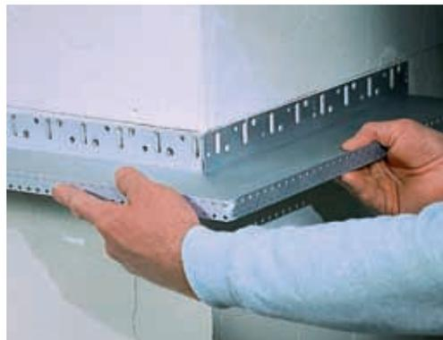
Figura 41. Detalle del perfil de arranque en una arista del edificio
