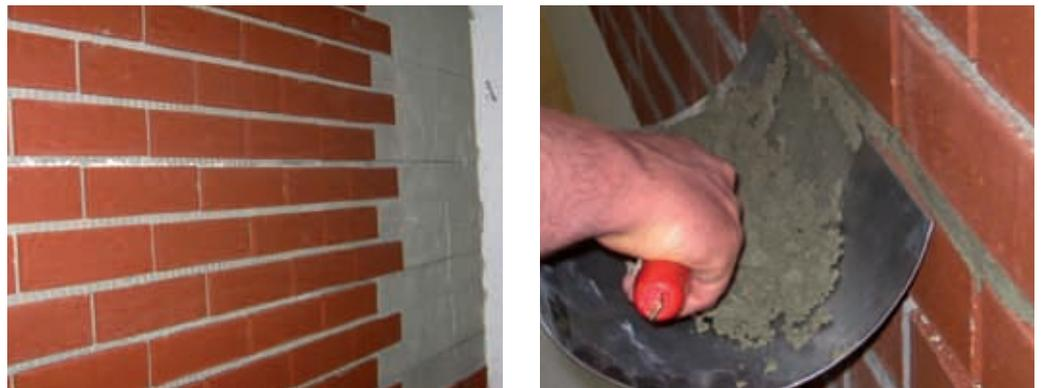
**Figura 38. Detalle de la instalación de un acabado de ladrillo sobre un sistema SATE**
