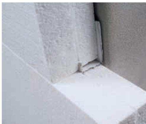
Figura 15. Fotografía que muestra el detalle de la unión del perfil con el panel aislante
