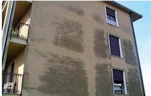
Figura 2. Edificio con defectos en los pilares y frentes de forjado
