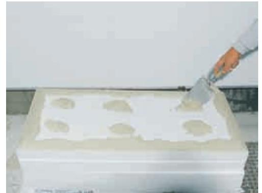
*Pegado borde-punto en una plancha de MW.*
