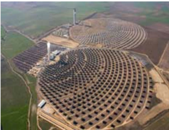
Figura 9. PS10 en operación junto a PS20 en construcción
