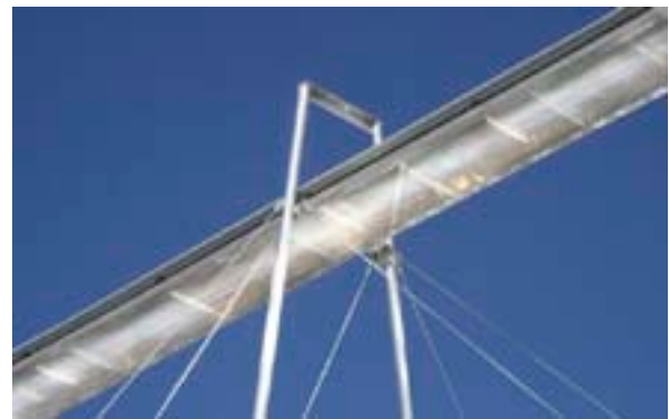
Figura 6. Tubos receptores de la planta CCLF de Kimberlina
