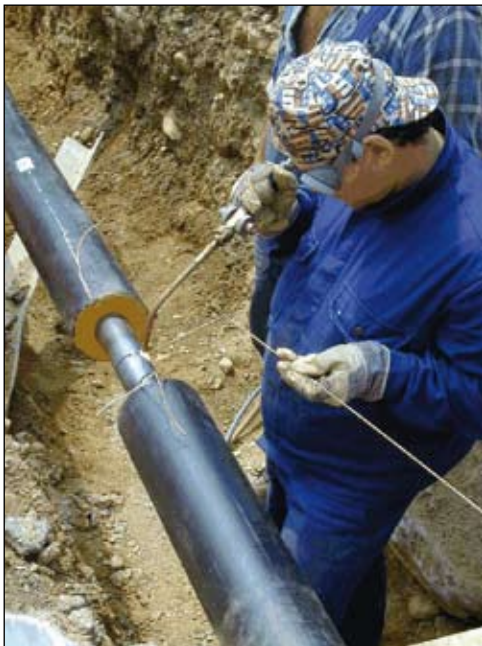
Soldadura en la red de tuberías de distribución de agua.
