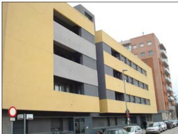
Barrio de Molins de Rei con red centralizada de calefacción.
