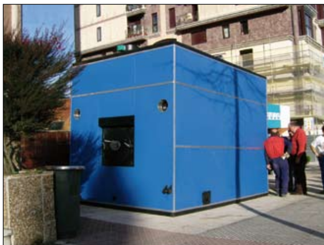
Instalación del módulo de las calderas.
