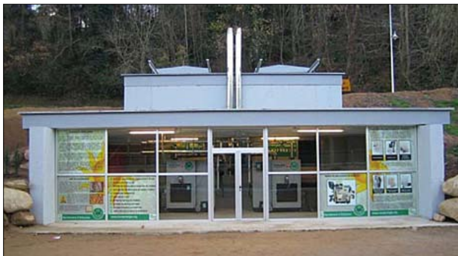
Planta central para red de distribución térmica.
