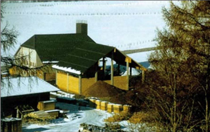
Instalación en Salzburgo (Austria).
