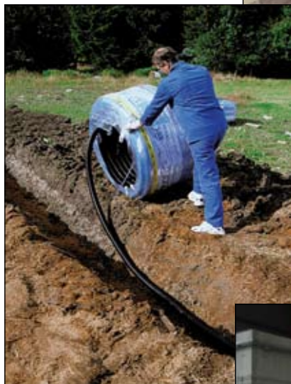
Instalación de tuberías.
