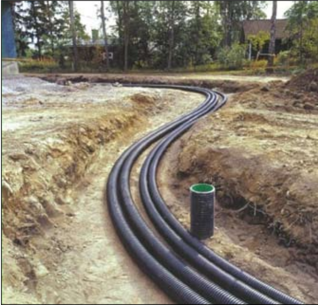
Instalación de las tuberías para red de distribución térmica.
