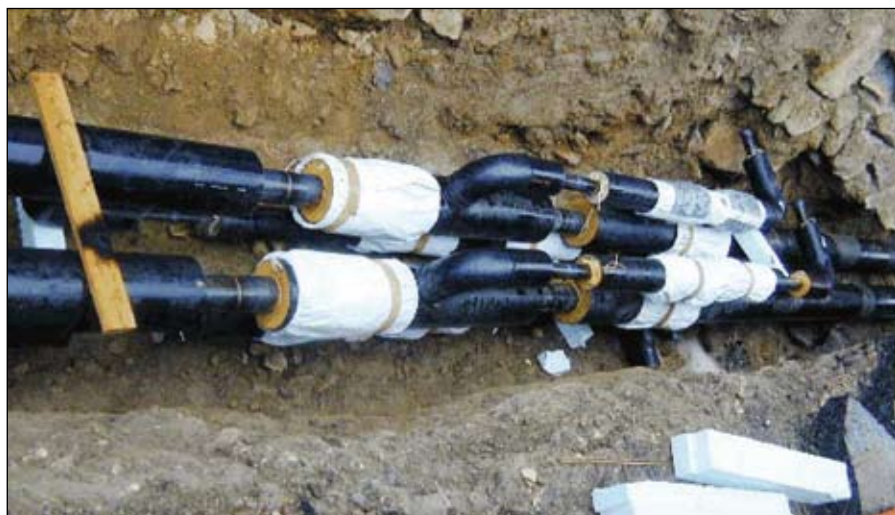
Montaje del aislamiento de la red de distribución térmica.
