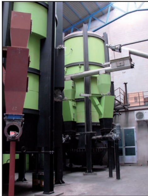
Vista del Gasificador nº 1 operativo y nº 2 en montaje.
