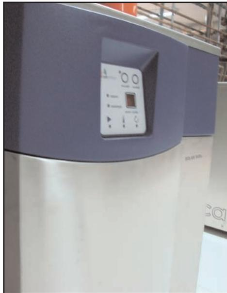
Una de las dos máquinas de absorción que forman parte del sistema de climatización de la Casa de la Cultura de Viana de Cega, Valladolid.
