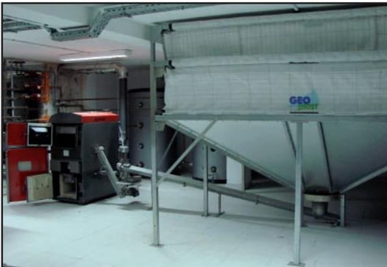
Silo de lona y alimentación a caldera del sistema de climatización (calor y frío por absorción). Casa de la Cultura de Viana de Cega (Valladolid).
