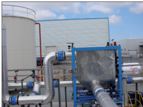
Arriba, filtro cerámico de syngas verde. A la derecha, soplantes y torre del scrubber. Fuente: GUASCOR.
