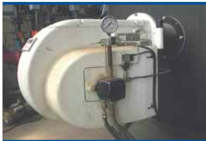
Foto 3. Quemador de doble llama
