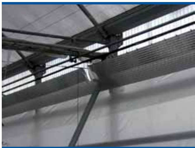
Foto 12. Láminas de sellado de las pantallas térmicas en su unión con los laterales del invernadero
